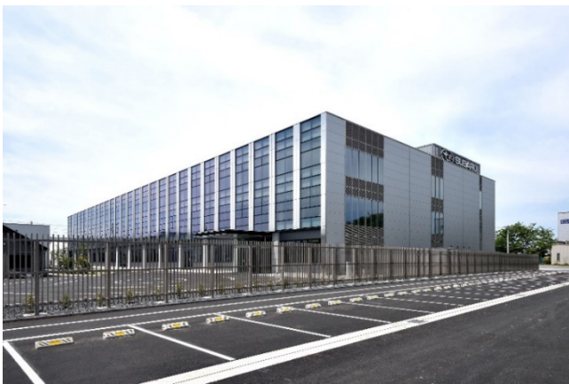
管理棟本館 外観
